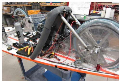
図 2 完成した電装系
