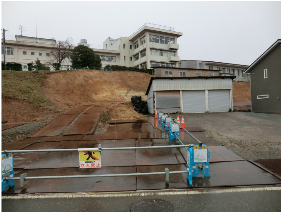
辰口中央小学校法面の崩壊(応急復旧済み)
