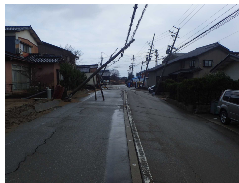
電柱の倒壊（内灘町西荒屋）
