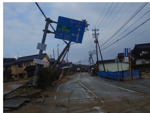
電柱の倒壊・道路の損傷（内灘町西荒屋）
