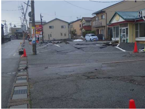
地盤の隆起（内灘町鶴ヶ丘）
