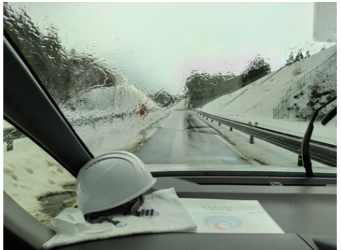
盛土部分の崩落や亀裂がある.
