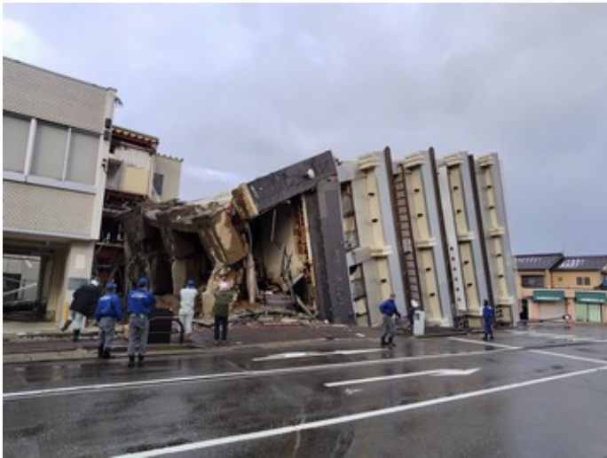
(株)五島屋ショールームの倒壊,基礎杭が抜けた部分に木材が見られる
