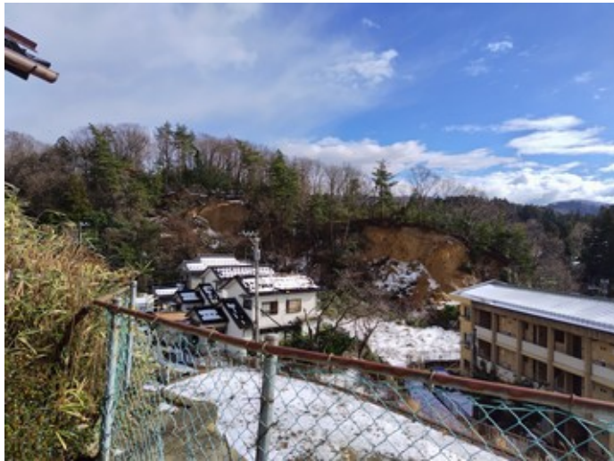
崩壊地の東側の別の尾根でも崩壊が認められる
