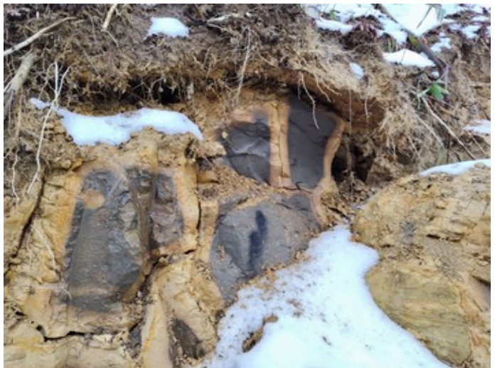
亀裂性に富みブロック状に風化が進行している
