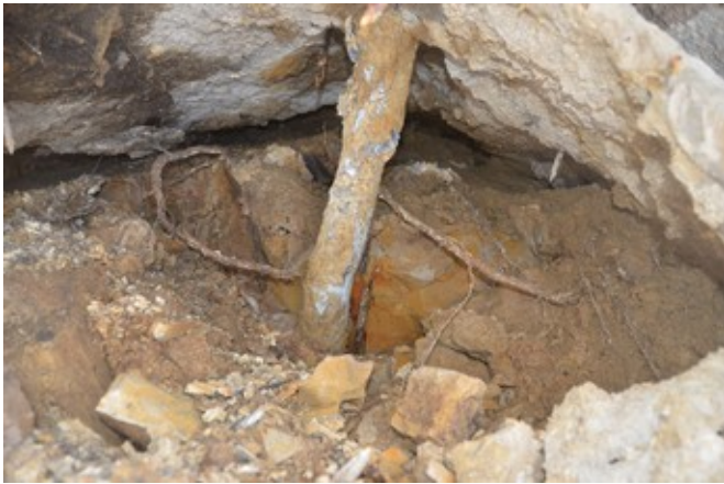
ロックボルトの様子
