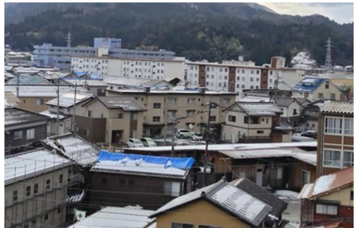
マンションの給水塔が傾いている。
