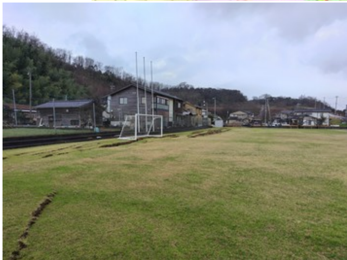
西荒屋小学校グラウンドの亀裂
