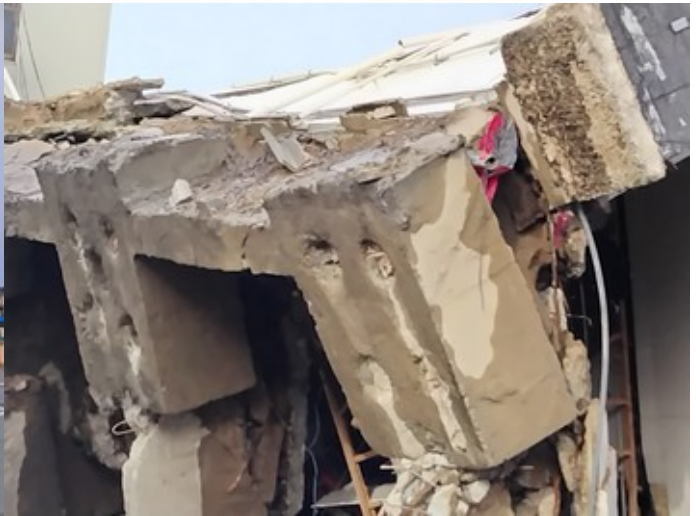
(株)五島屋ショールームの倒壊,基礎杭が抜けた部分に木材が見られる
