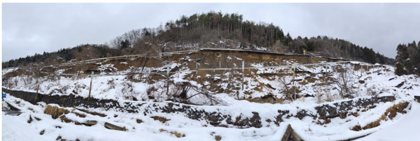
本線の谷側も崩落.
