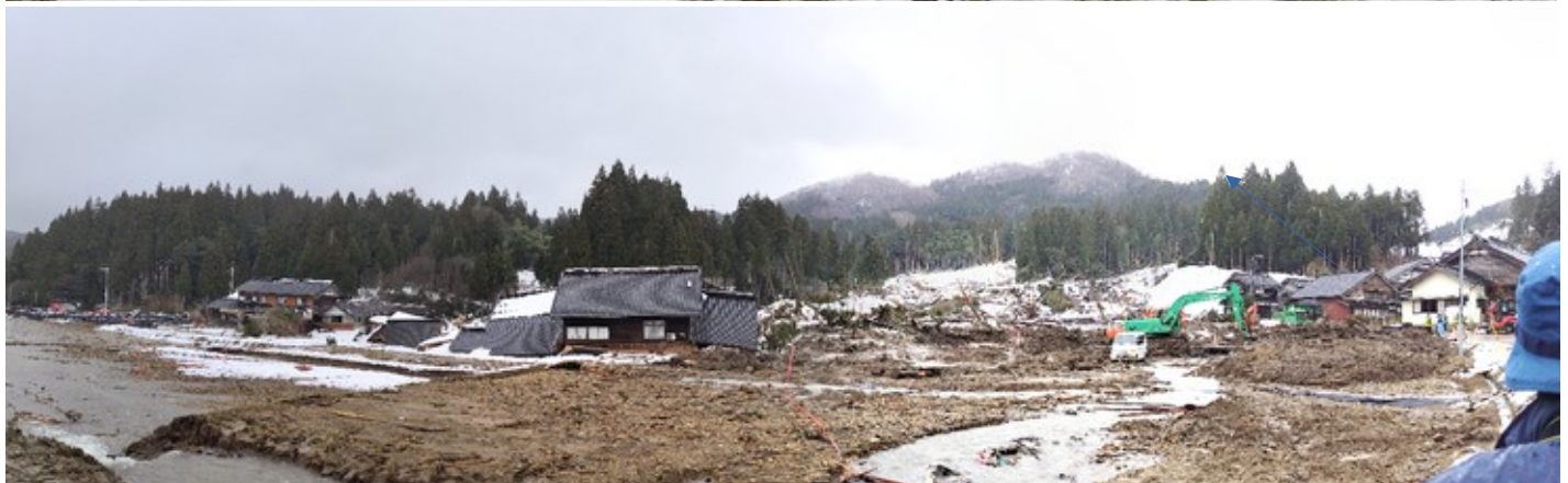
末端部の様子(崩壊上部は救出活動中のため撮影せず.)
