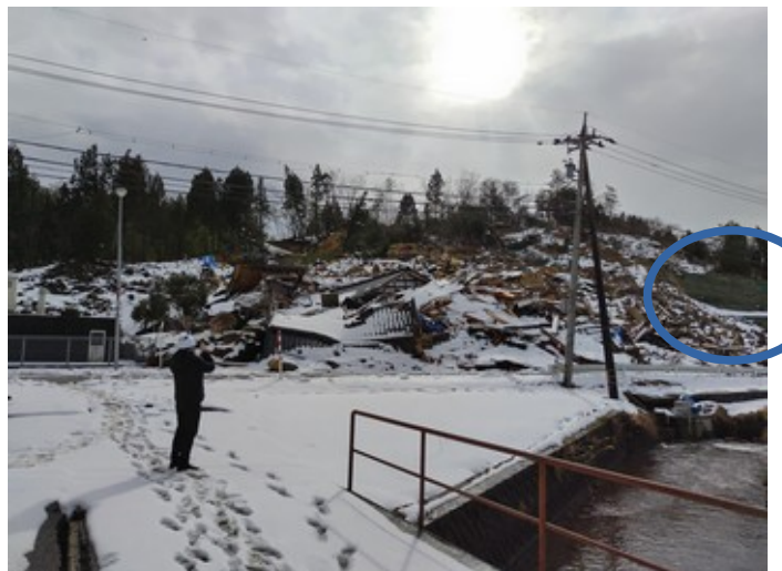
ネット対策工を施工中の崩落
