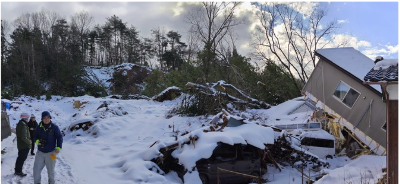
家屋には土砂がかぶっておらず,地盤ごと押されて移動したように見える
