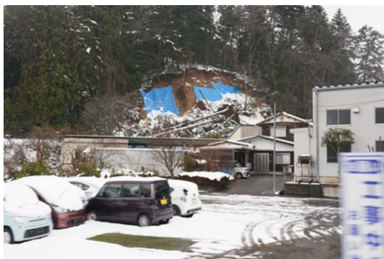
穴水町乙ヶ崎の斜面崩壊
