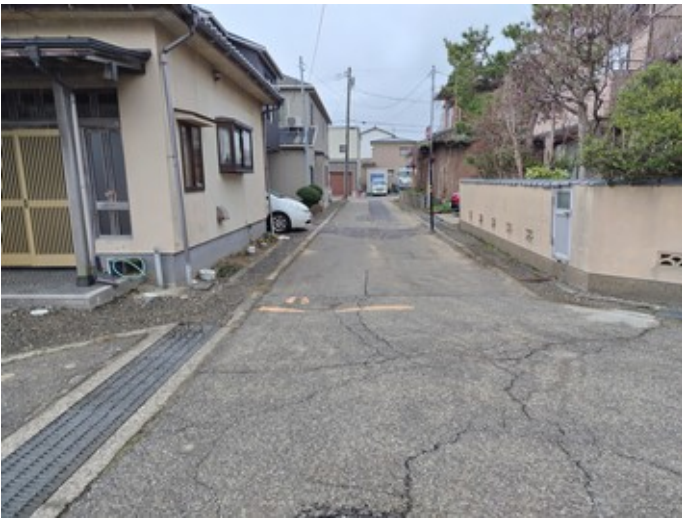
9.平坦部も液状化の痕跡はあるが,大きく動いていない 10.液状化により全体的に沈下している可能性あり
