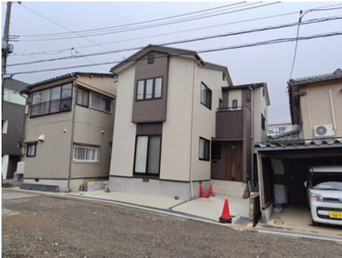
6. 亀裂による家屋被害
