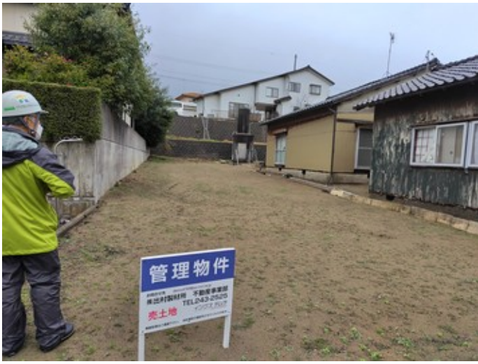
36. 空き地の変状
