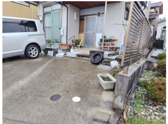
19.家屋と敷地の段差
