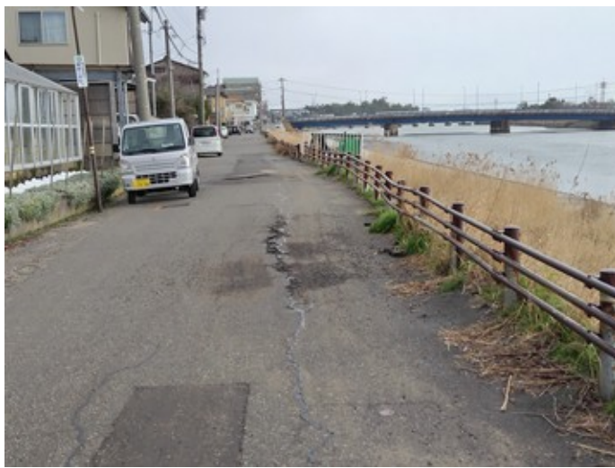
10.河川護岸には被害がない
