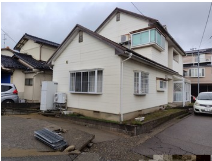
41.おそらく下方に全体が移動している
