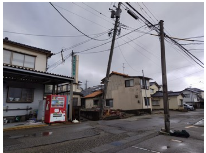
40. 家屋の沈下および傾斜
