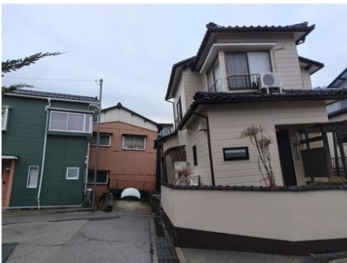
25.家屋の傾き(右手前,真ん中奥ともに)
