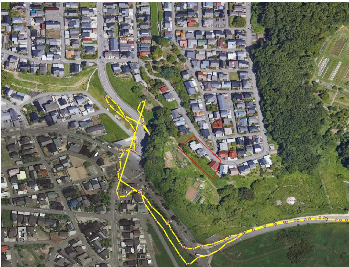
宅地造成地の盛土部分の崩壊。(写真赤囲み)
