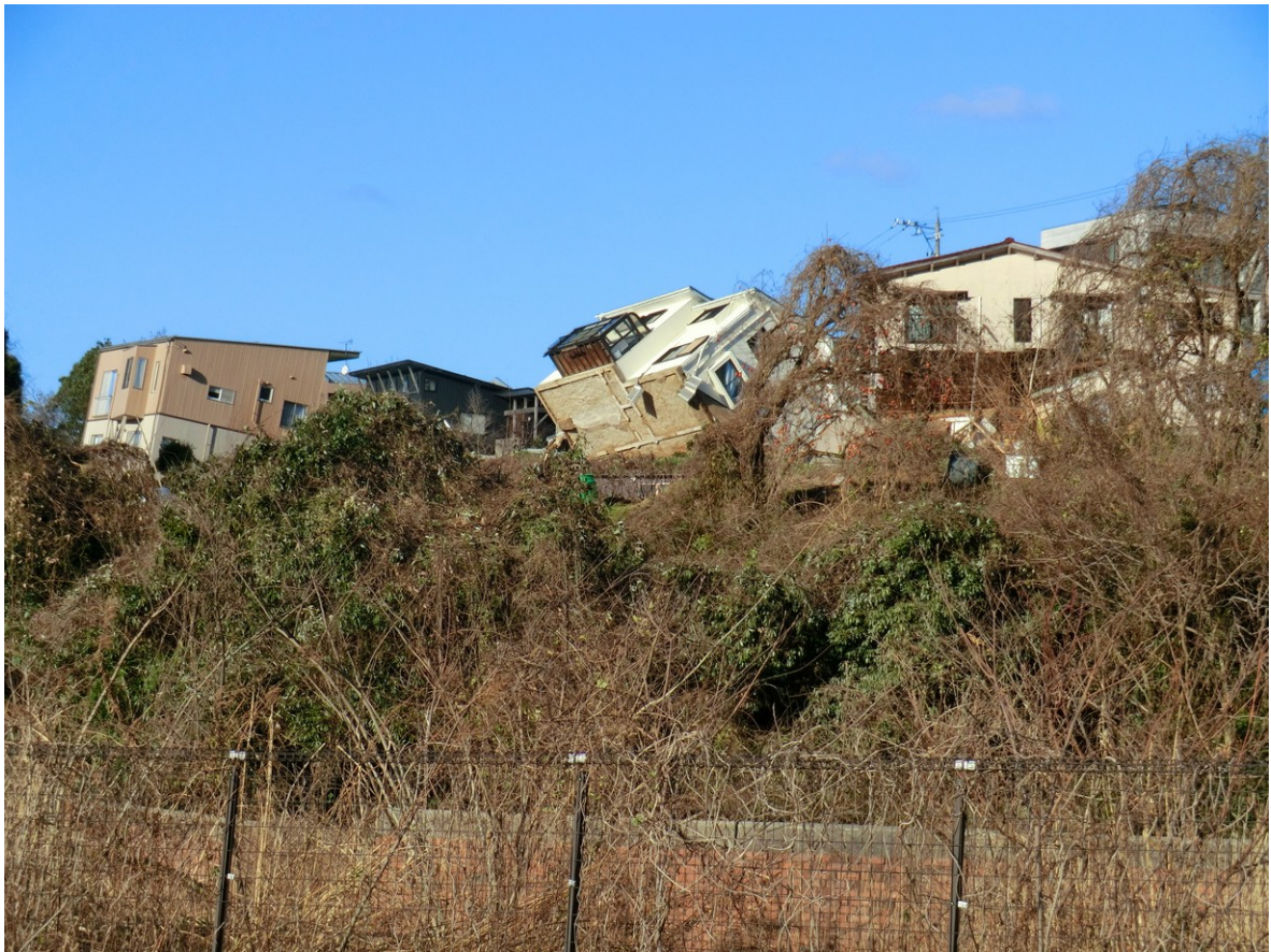
宅地内道路端の4棟が被害(撮影:高原)
